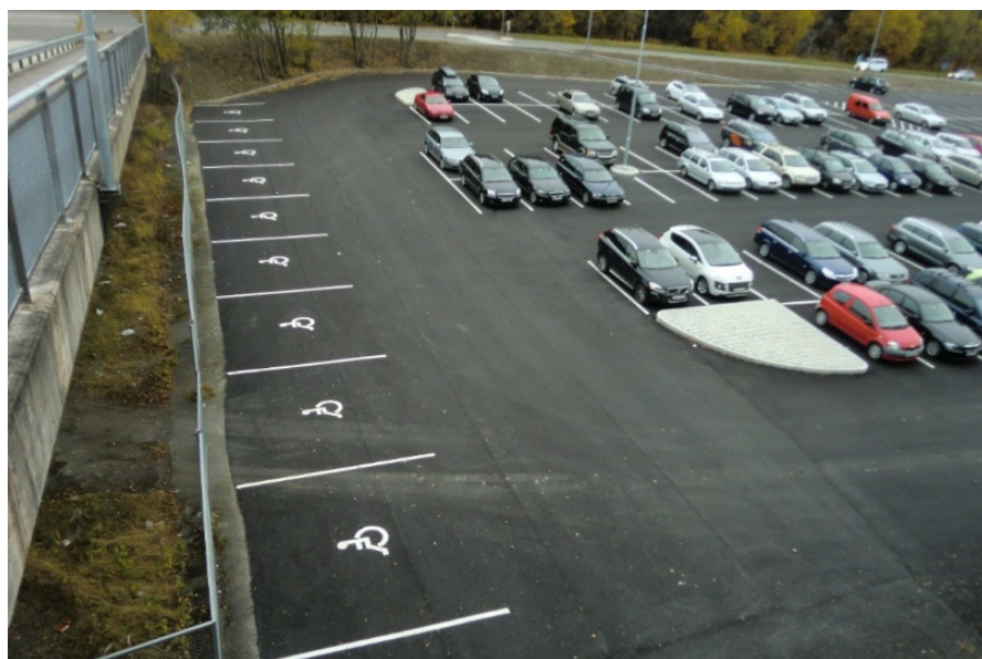
Figur 19 Reserverte parkeringsplasser for HC på Rosenholm pendlerparkering som ligger på grensen mellom Oslo og Oppegård kommune. Foto: Jan Usterud Hanssen.
