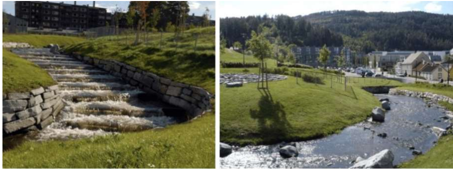
Figur 1. Ilabekken i Trondheim etter gjenopning, med fisketrapper og gyteområde for sjøaure. Foto: Trondheim kommune.
