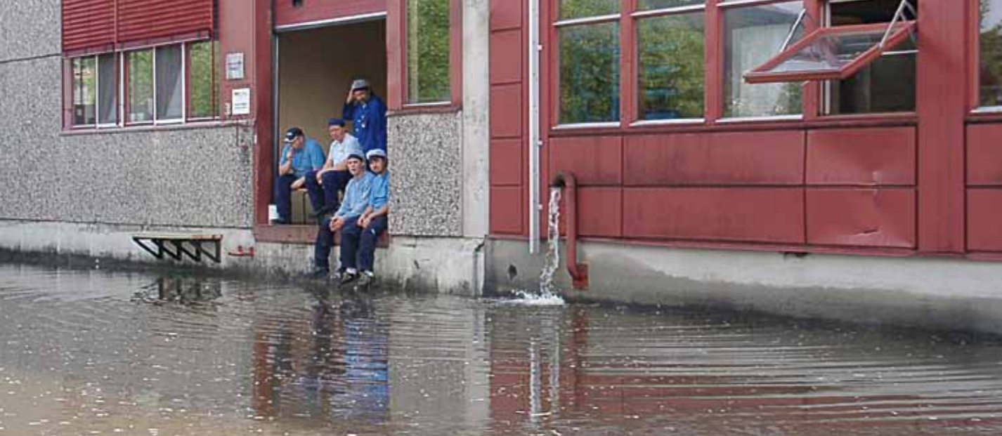
Ved storflom er det kort vei ned til Drammenselva for disse ansatte ved en bedrift i Drammen.
