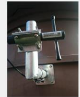
Sensorer montert under bakken i kommunens vann- og avløpsledninger. Måler overløp, trykk, mm.
