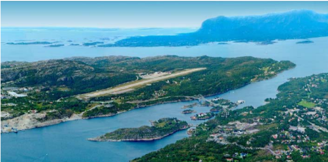
Figur 32 Forlengelse av rullebanen på Kvernberget med ca 600 m er blant tiltakene som får infrastrukturmidler i forbindelse med sammenslutningen. Reguleringsplan med konsekvensutredning for tiltaket ble framlagt i januar 2006 (kilde: KU-rapport).
