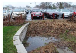
Regnbed som fanger opp overvann fra parkeringsplass ved University of Minnesota, St. Paul, USA. Vannet infiltrerer ned til grunnen mens forurensningen forblir i filtermediet.
